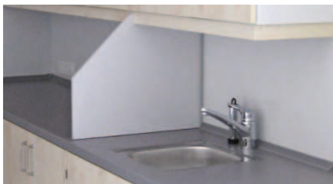
HPL-Arbeitsplatte mit flächenbündig eingebauter Edelstahlspüle
